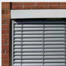
President monterad på utsidan av fönsterkarmen
